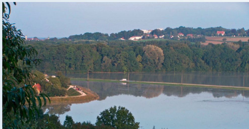
Der neue Deich im Eulatal bewährte sich bereits beim Hochwasser 2005
